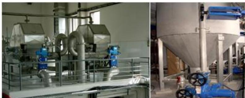
На входе используются ступенчатые решетки с прозором от 1 до 3 мм. Отложения, улавливаемые на наклонных ступенях решётки действуют как дополнительный фильтр, улучшающий результат работы. Удаление шлама осуществляется тогда, когда из-за растущего гидравлического давления увеличивается уровень воды в лотке перед решеткой.
