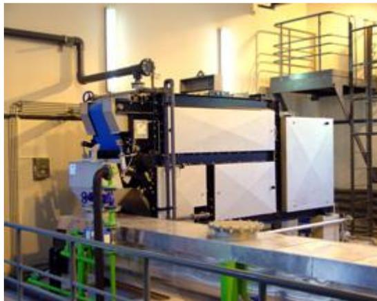
Избыточный ил обезвоживается в автоматическом цехе, где в состав сооружений могут входить сгуститель, узел приготовления и дозирования флокулянта, ленточный фильтр-пресс, компрессор, насосы промывки лент фильтра, подачи осадка. Управление технологическим процессом осуществляется с помощью специального контроллера.
