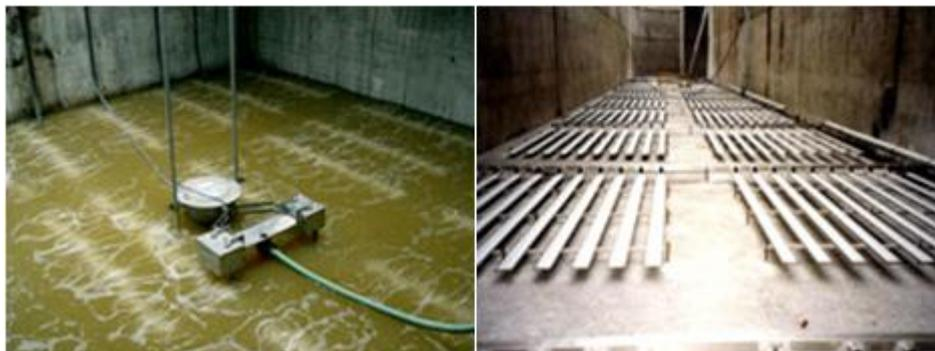
Поступающие сточные воды со стадии механической очистки для соблюдения переменного режима работы биореактора временно задерживаются в накопителе, оснащенном плавающей мешалкой и насосом подачи в биореактор.
